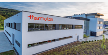
Bedrijfslocatie (5.300 m 2 ) in Mittenaar-Offenbach (administratie en verkoop)
