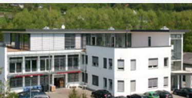
Tweede fabriek (1.100 m 2 ) in Mittenaar-Bicken (SMD assemblage en fabricage)
